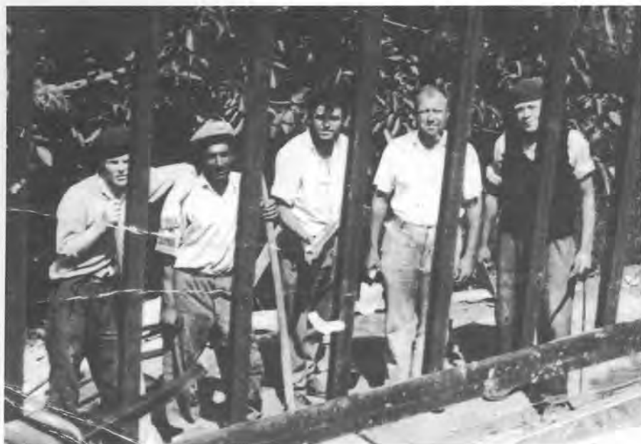
Bukovits Rudolf a Sió-csatorna építésén, 1947
