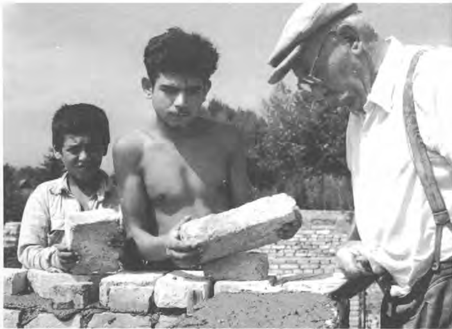
Vilovits István segít a Rontó család lakásának építkezésénél, Felsőzsolca, 1963
